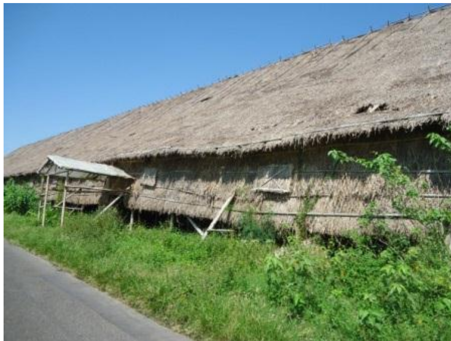
Gambar 12: Penutup atap & pelingkup dari rapak KM 35 (Sumber: Dokumentasi Saraswati, 2019)
