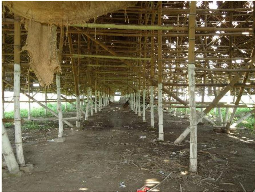
Gambar 10: Umpak batu dengan jontong di KM 33 (Sumber: Dokumentasi Saraswati, 2019)
