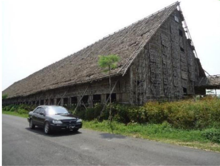
Gambar 17: Tampak memanjang GT 14, Desa Karanglo (Sumber: Dokumentasi Saraswati, 2019)
