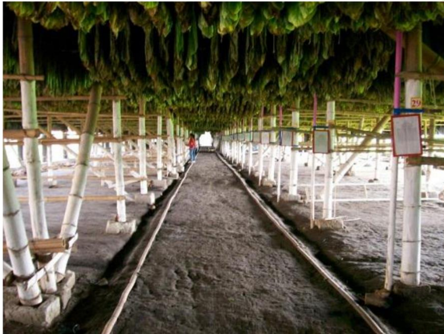
Gambar 14: Lantai dari tanah, parit kecil diberi pembatas bambu, terlihat daun tembakau digantung (Sumber: Dokumentasi Saraswati, 2008)
