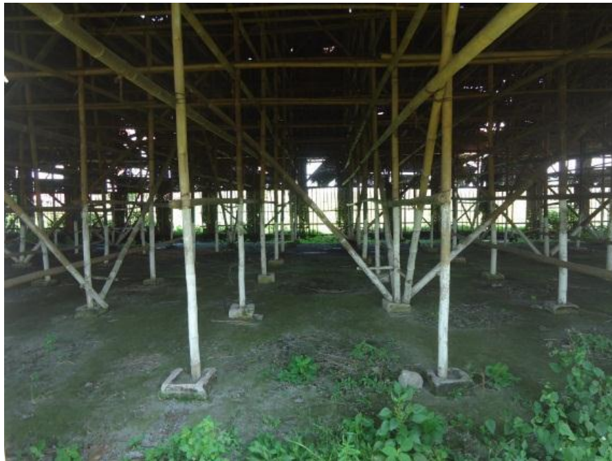
Gambar 11: Umpak batu dengan jontong di KM 37 (Sumber: Dokumentasi Saraswati, 2019)
