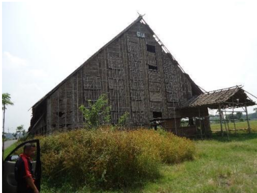
Gambar 16: Tampak membujur GT 14, Desa Karanglo (Sumber: Dokumentasi Saraswati, 2019)
