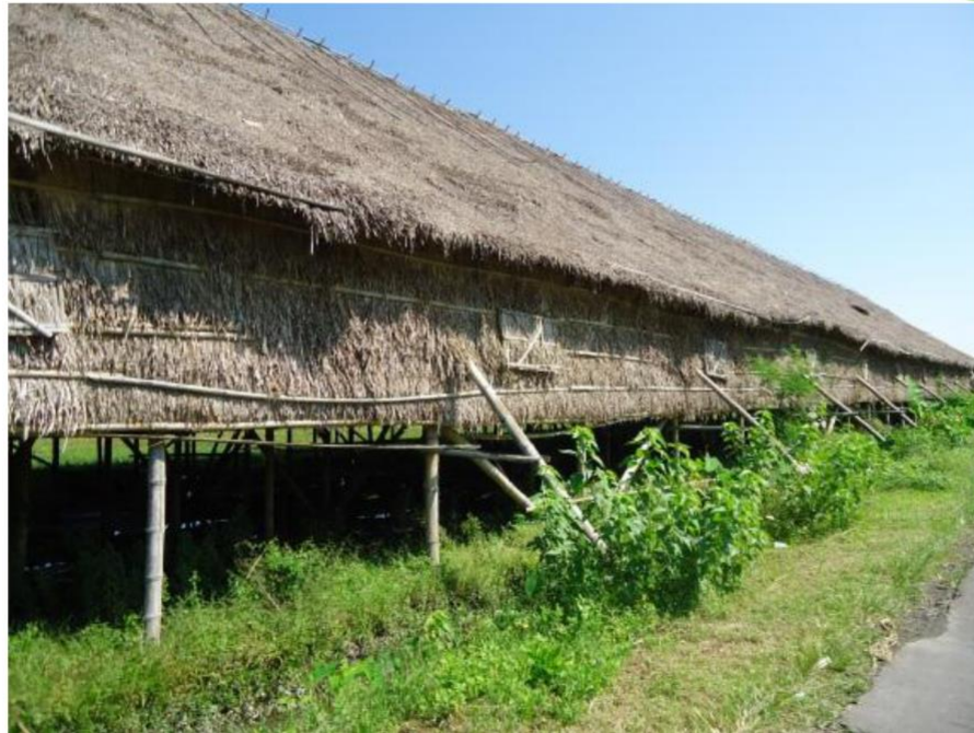
Gambar 8: Tampak memanjang Los KM 35 di Kebonarum, Desa Pluneng (Sumber: Dokumentasi Saraswati, 2019)
