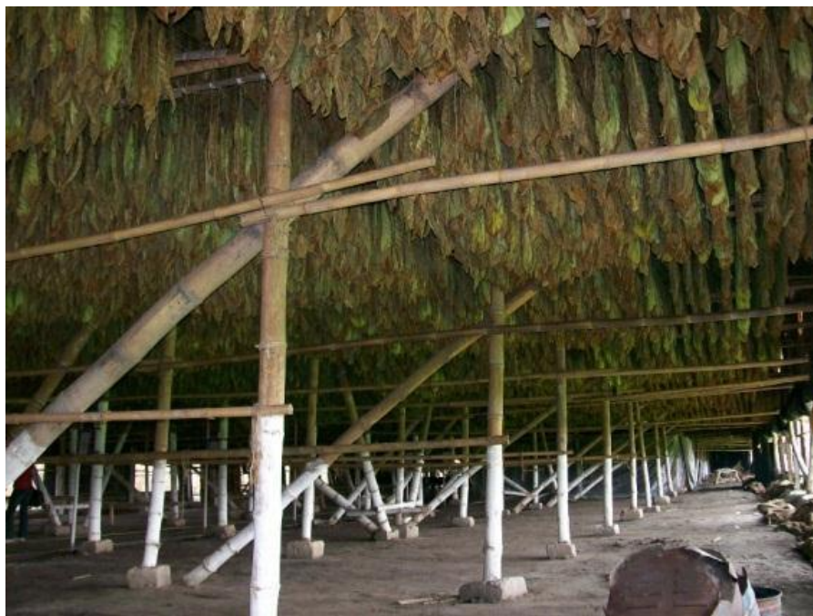
Gambar 15: Planthangan dan ethek , berfungsi untuk menggantung dolok (Sumber: Dokumentasi Saraswati, 2008)
