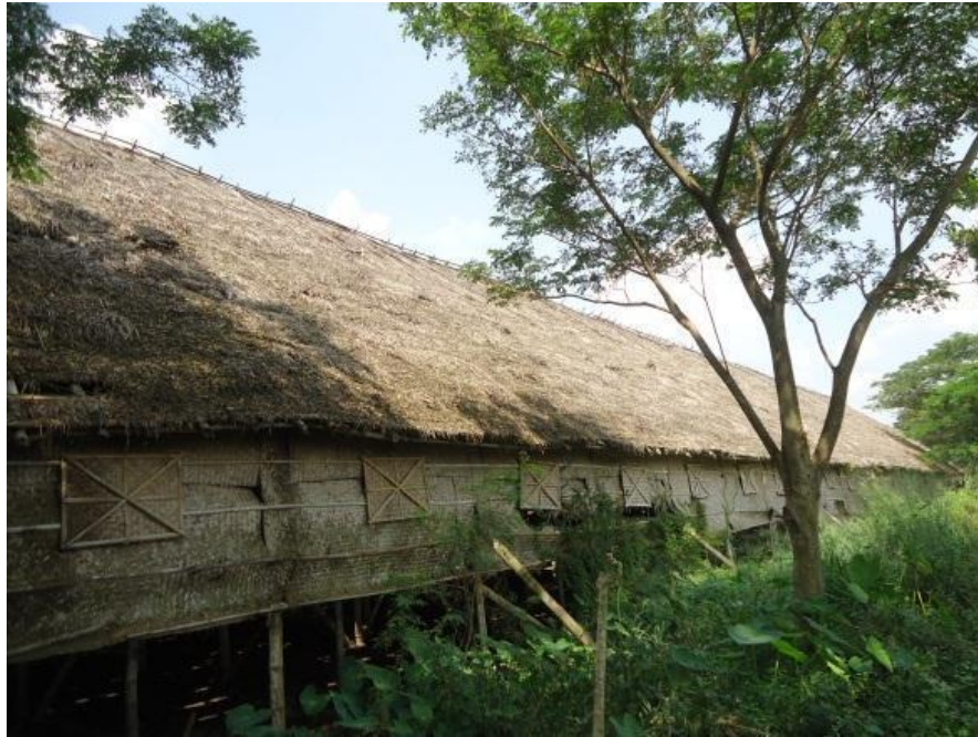
Gambar 13: Penutup atap & pelingkup dari rapak WT 42 (Sumber: Dokumentasi Saraswati, 2019)
