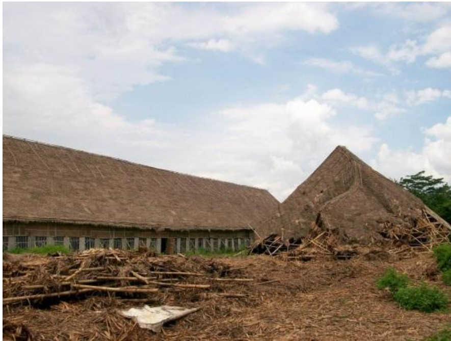
Gambar 2: Los yang ambruk karena puting beliung di Kabupaten Jember (Sumber: Dokumentasi Saraswati, 2010)
